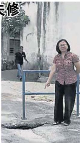
罗丽娟指“口袋公园”的栏杆已脱落和损坏。
